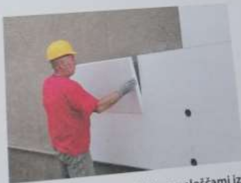
Zunanje stene hiše obložimo s ploščami iz stiropora, da zmanjšamo toplotne izgube. So tudi izolator zvoka.
